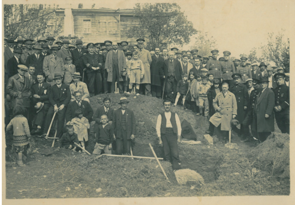
Paşasuyu İnşaatı temel atma töreni (1932) (KBB Arşivi)
