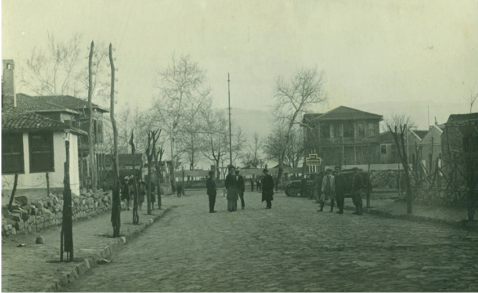
Yıl 1929, Eski Postane Caddesi inişi ve sağdaki iki katlı bina, Belediye Oteli ve Lokantası. (KBB Arşivi)
