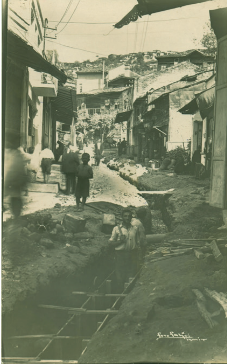
Çarşıbaşı'na kanalizasyon yapımı çalışmaları (1944) (KBB Arşivi)
